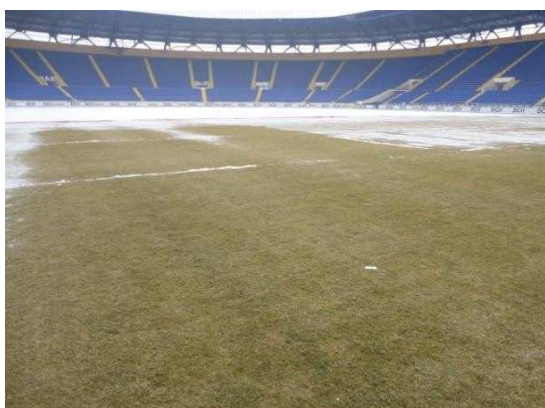
Slabo delujoč sistem za podzemno gretje, zaradi katerega je na nekaterih delih igrišča še vedno zmrzal ali sneg.
