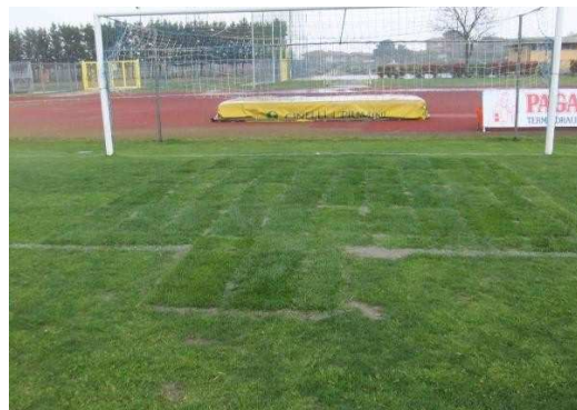
Slabo nivelirana površina v prostoru pred vrati, kjer je bila zamenjana trata.
