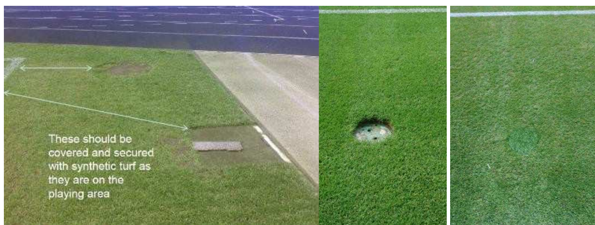
Slika 28 – Odprtine in servisne škatle v varnostni coni okoli igrišča.
