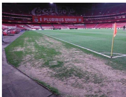
Poškodovan pas okoli igrišča zaradi premalo svetlobe in preveliko prometa.
