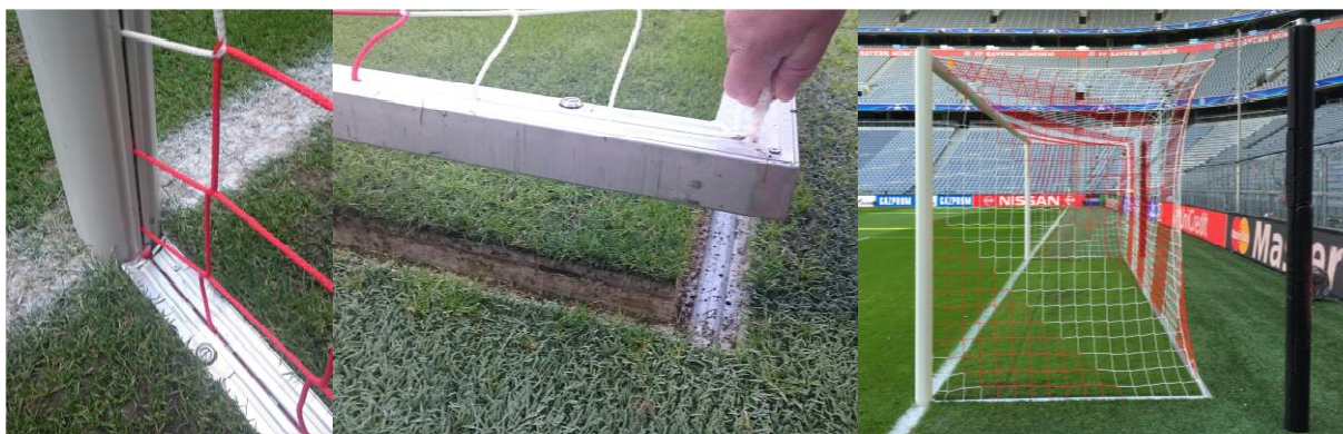
Slika 24 – Okvir vrat, vgrajen v tla.
