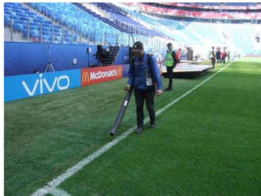
Mokra barva – pospešite sušenje črt s pihalnikom za listje.
